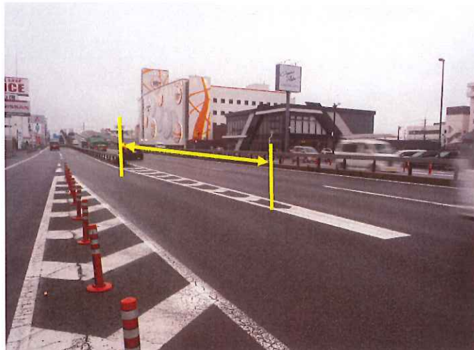
豊成下りOFFランプ 車線分離標設置
