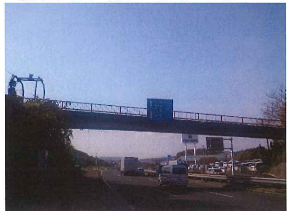
②標識板移設
