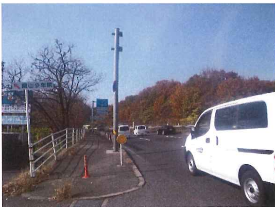
①標識柱の撤去
