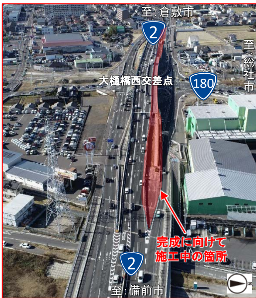
大樋橋西交差点の様子(令和4年12月)
